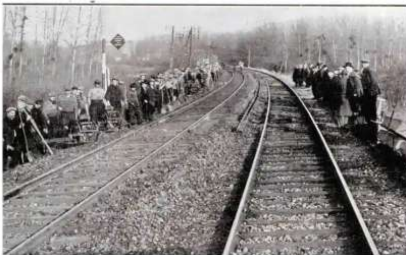
Cantonniers au travail, par « brigades » très nombreuses, sur le réseau de l'Est en 1938. Une « période » est le temps disponible, dégagé par les régulateurs, pour permettre de travailler sur les voies, avec absence de tout train.
